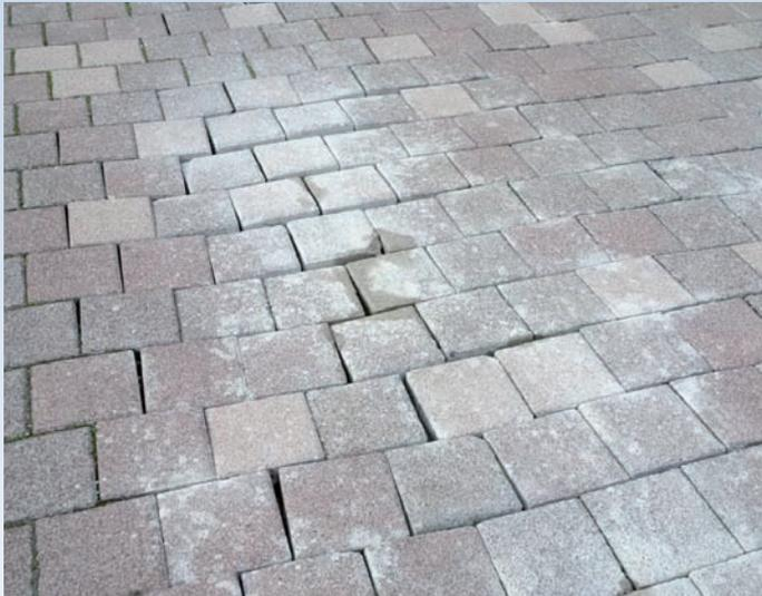
Bild 2: Setzungen aufgrund undurchlässiger Schichten
