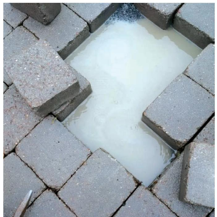
Bild 1: Wasserundurchlässige Tragschicht (Fotos: A. Eichler)
